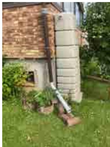
Exemple de débranchement et mise en place de cuve de récupération des eaux pluviales
